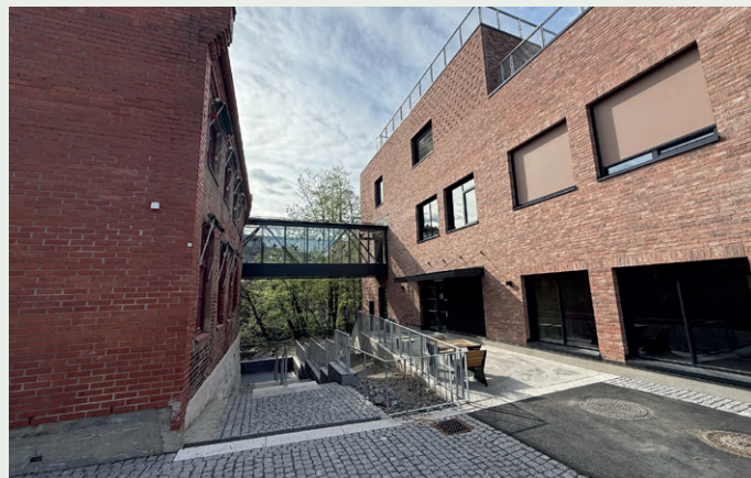
En glassbru binder nytt og gammelt bygg sammen.
