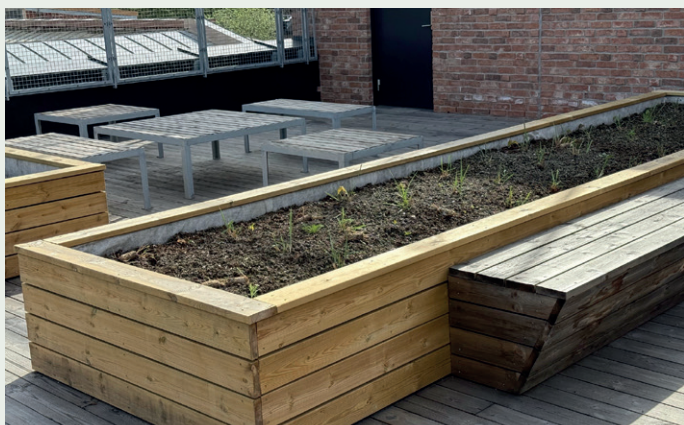
Takterrassen vil nok bli mye brukt.
